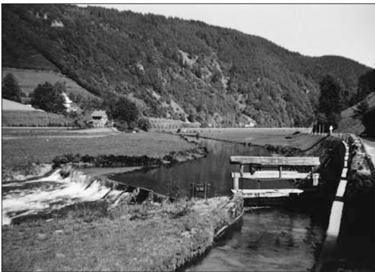
Abb. 6: Das Scheidwaagwehr in der Kinzig oberhalb von Schiltach mit der Einlassfalle (rechts) am Anfang des Grethel-Kanals. Foto: Herbert Pfau
