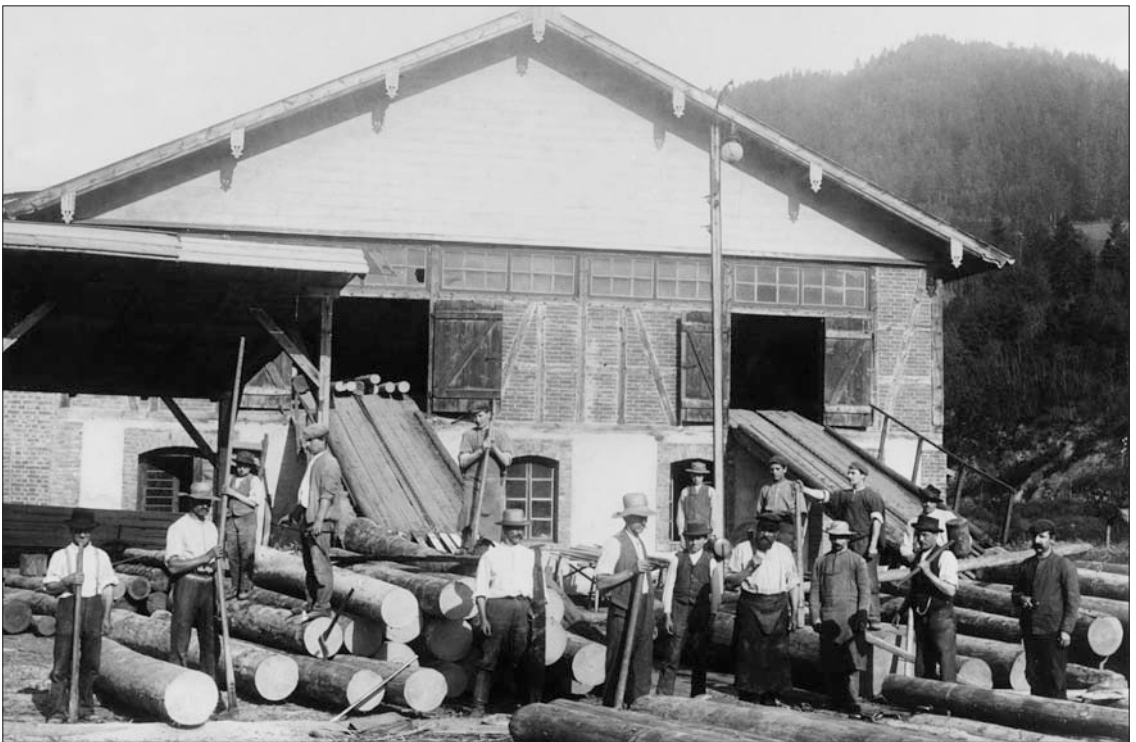
Abb. 8: Auf dem Platz neben dem Sägegebäude waren die Arbeiter mit dem Zurichten der Stämme beschäftigt. Mittels Kettenzügen wurden die Hölzer dann über schräge Rutschen in den ersten Stock transportiert und zu Balken, Brettern und Dielen verarbeitet. Bildarchiv der Stadt Schiltach
