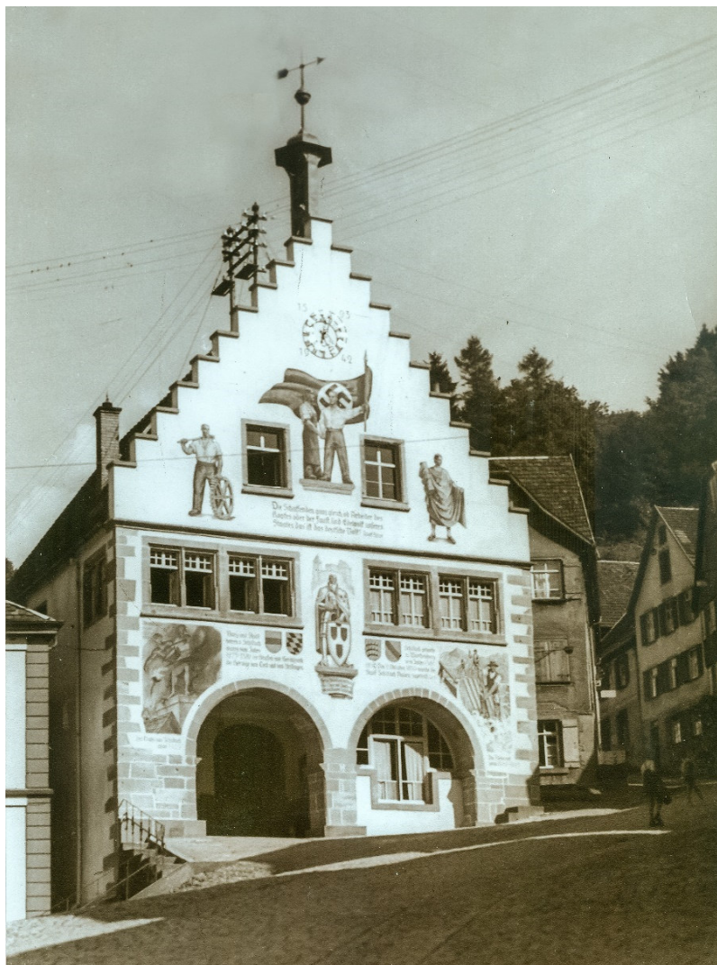
Abb. 9: Die Rathausfassade nach ihrer Erneuerung 1942 48
