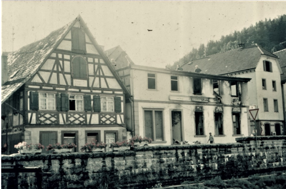
Die Brandruine wurde schließlich abgerissen ...
