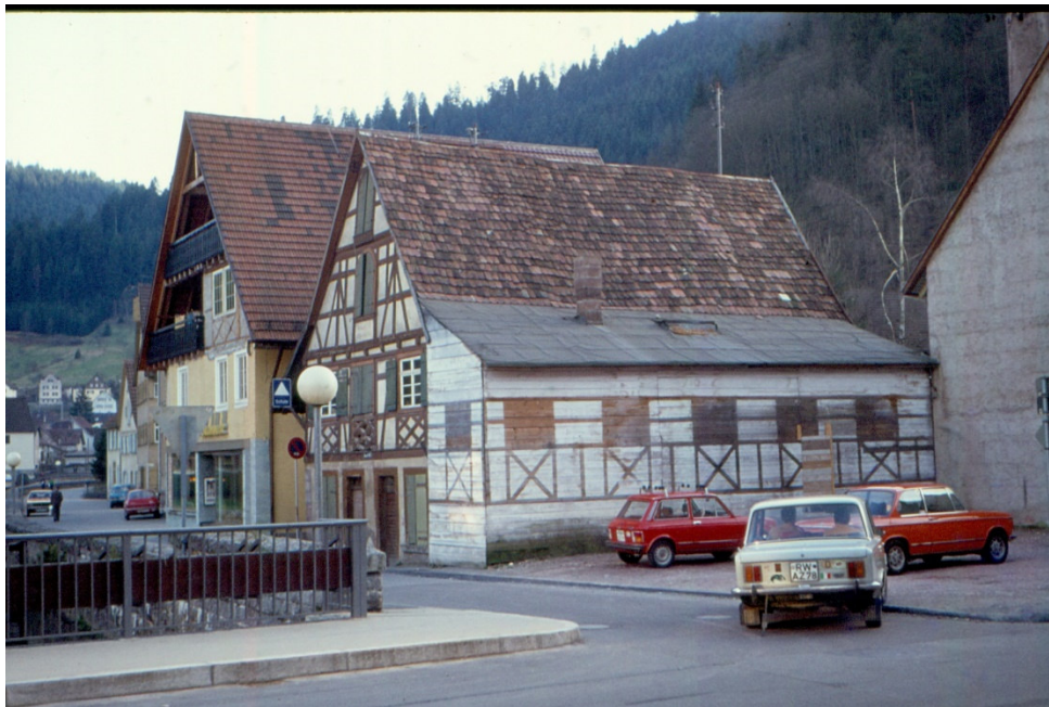
... und das Grundstück übergangsweise als Parkplatz genutzt
