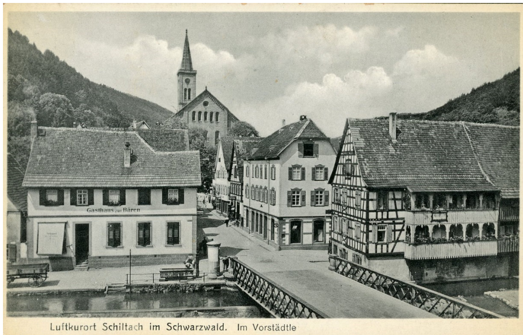
Das Vorstädtle vor der Sanierung, links der ehemalige „Bären“
