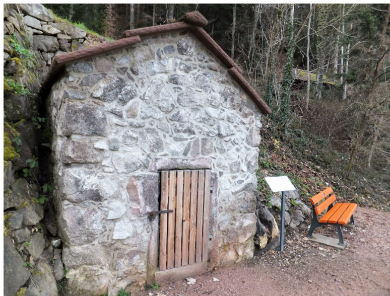
Das Pulverhäusle 2022 nach erfolgreicher Sanierung Foto: R. Mahn
