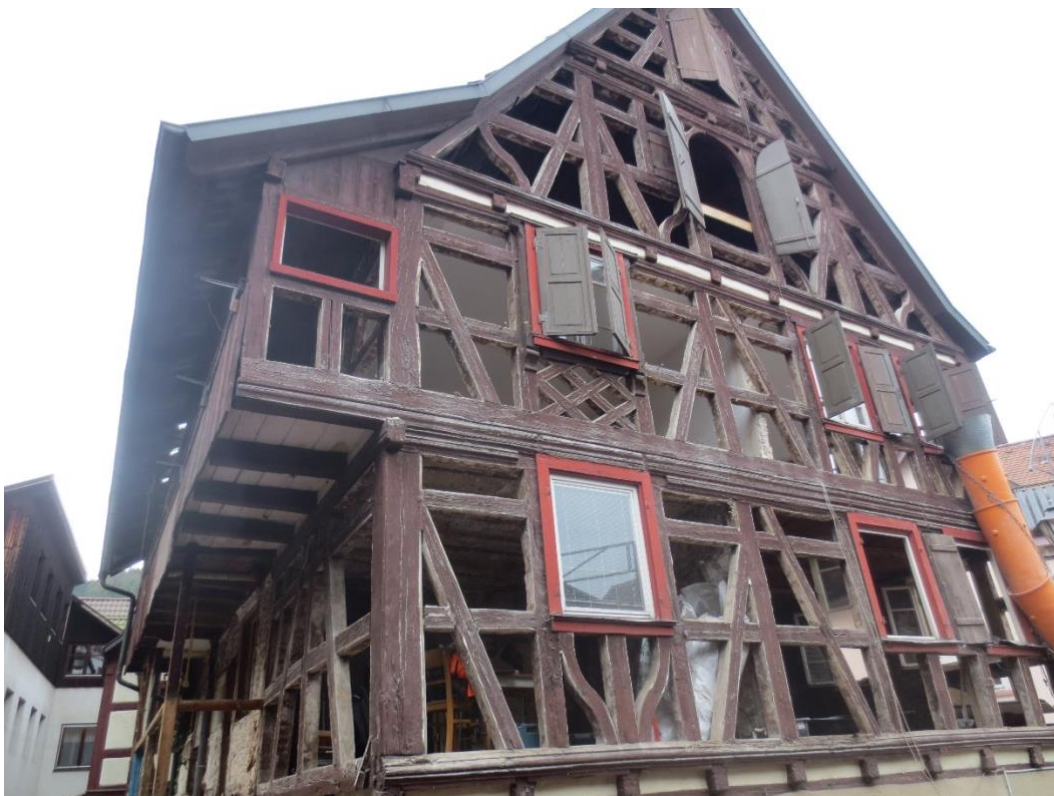
Die kürzlich freigelegte Fachwerkkonstruktion von 1680.
