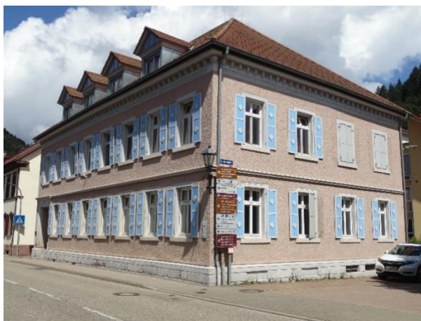
Abbildung 6: Das „Engelsschulhaus“ 2019, zwei Jahre vor dem Abriss.
