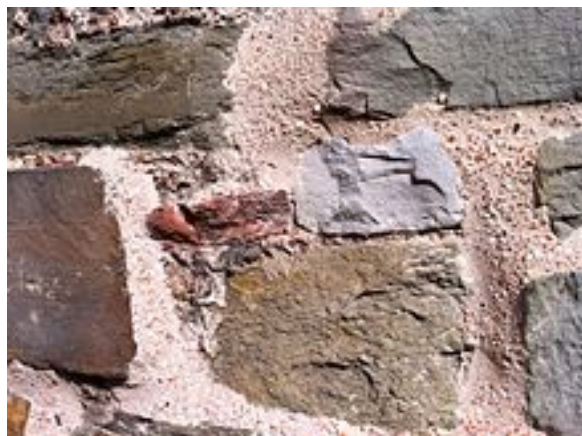
Bild 5: Mauerwerk des Aachener Domes aus Mörtel mit rotem Ziegelsplitt Quelle: wikipedia.org/wiki/Aachener_Dom
