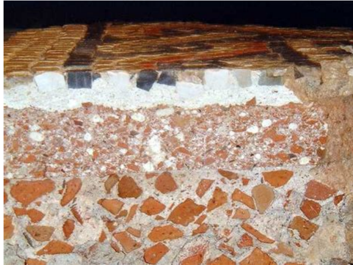
Bild 1: Ziegelbrocken in römischen Betonplatten unter einem Mosaikboden. Quelle: Andreas Hopson-Münch: Forum Traini, Römische Baukunst
