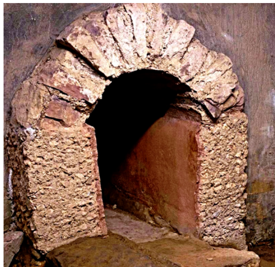
Bild 2: Mörtelputz mit Ziegelmehl (Splitt) an den Innenwänden einer römischen Wasserleitung Foto: picture alliance/akg/ Bildarc
