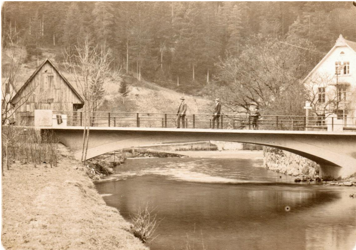
Die noch 1925 fertig gestellte Bogenbrücke (Blick von Süden)...
