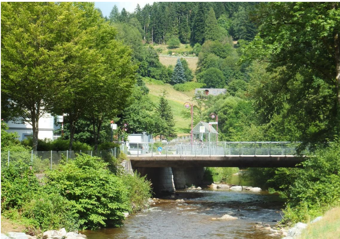
... und der sie ersetzende Neubau von 1997 (Blick von Norden)
