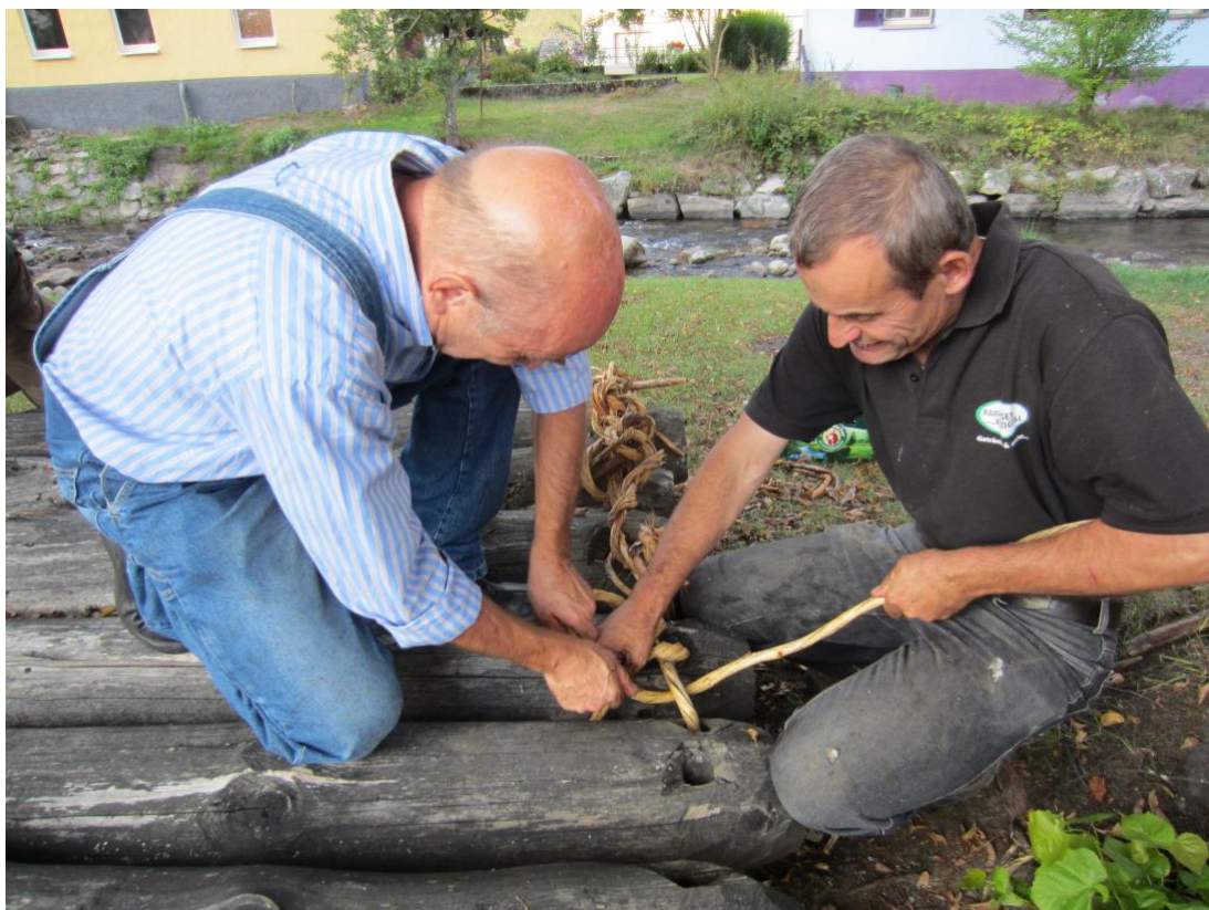
Durch die Bohrlöcher werden die Stämme mit Wieden verbunden ...
