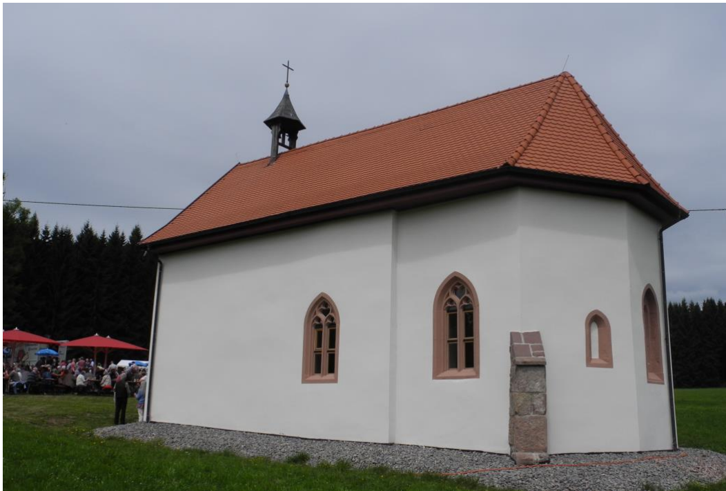
Die nach einer grundlegenden Sanierung im Jahr 2017 wieder eröffnete St. Georgs-Kapelle Foto: Mahn
