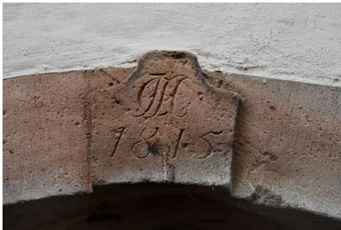
Hauszeichen am Kellerausgang in der Stadtmauer: „JCA“ = Johann Christian Armbruster II., Hirschwirt. Foto Harter
